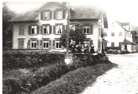
▲ Links der Lauf des Mühlbaches, rechts die Wasergasse, die in die Staatsstrasse mündet. Im Hintergrund das ehemalige Café Locher, heute das eben fertig renovierte Gewerbehaus «Gettnuu».
