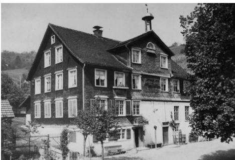
▲ Im Gasthaus Glocke fand die Gründungsversammlung der WWK statt. Dieses Gebäude musste einem Neubau weichen. Nur das kleine Türmlein ist noch auf der Einfahrt der neuen Tiefgarage zu sehen.
