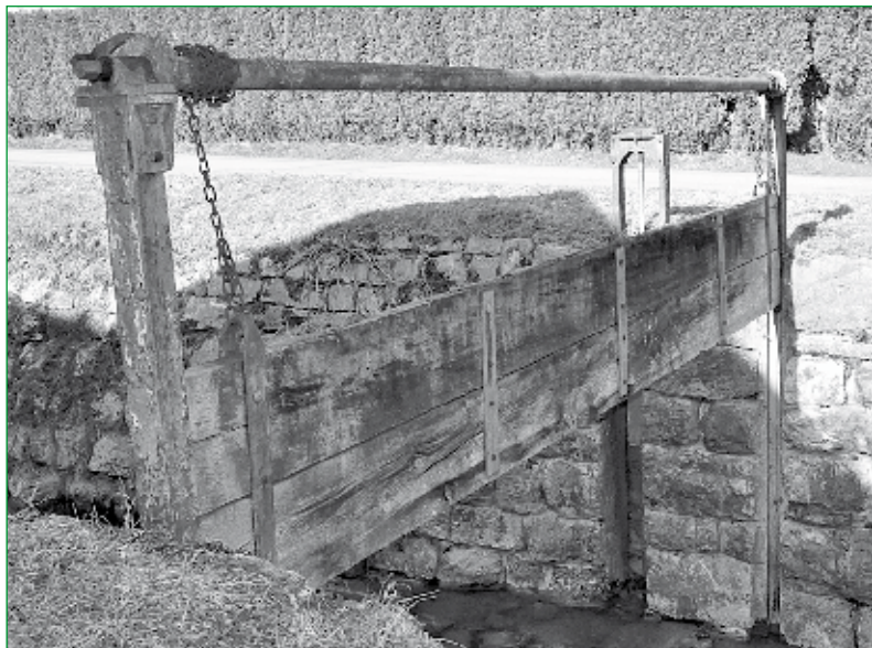
Relikt aus vergangenen Tagen: Mit Wassersperre und Schieber bei der Erlenbrücke konnte Löschwasser ins Holand abgeleitet werden.
