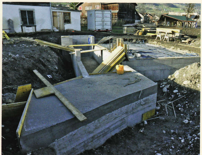
Betoniert: Fertig sind Kanal und Fundament für die Messerschmiede.
